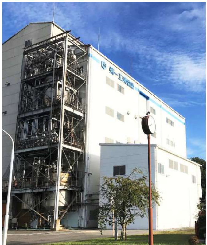
▲ 第一工業製薬株式会社 SE工場外観
